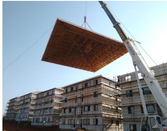
Figura 4 – exemplo de construção industrializada; Fonte: Tecverde
