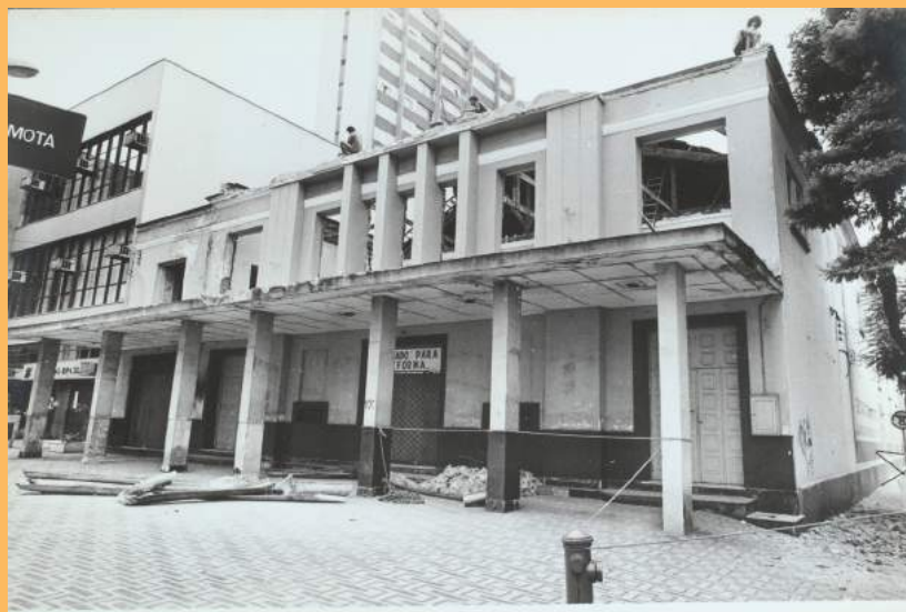
Início da demolição da fachada do Cine Theatro Carlos Gomes, 1988. Coleção PSA. Acervo MSAOAG.
