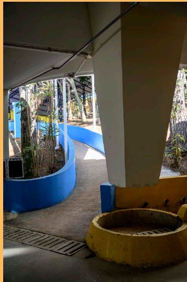
Acesso entre a laje terraço e as salas de aula, à direita, coletor de águas pluviais em concreto armado. Foto: Beto Garavello, julho de 2022. Coleção CTAPC.
