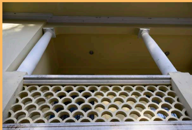
Colunas que remetem à antiguidade clássica e guarda corpo constituído de elementos vazados em forma de meia lua fazem o fechamento da varanda. Composições típicas em construções Neocoloniais luso-brasileiras. Foto Beto Garavello, julho de 2022. Coleção CTAPC.
