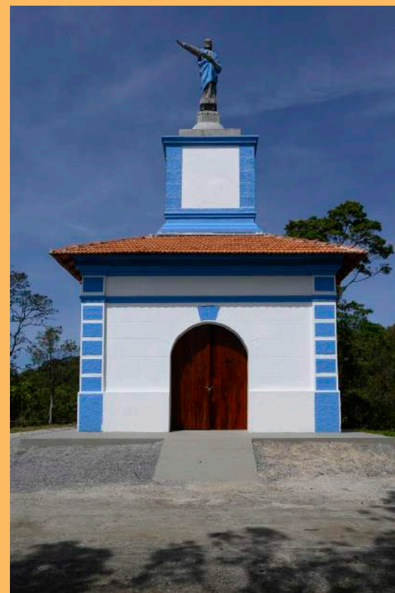
Fachada frontal da Capela de São José da Boa Viagem, após intervenção finalizada em agosto de 2022. Foto Beto Garavello, setembro de 2022. Coleção CTAPC.
