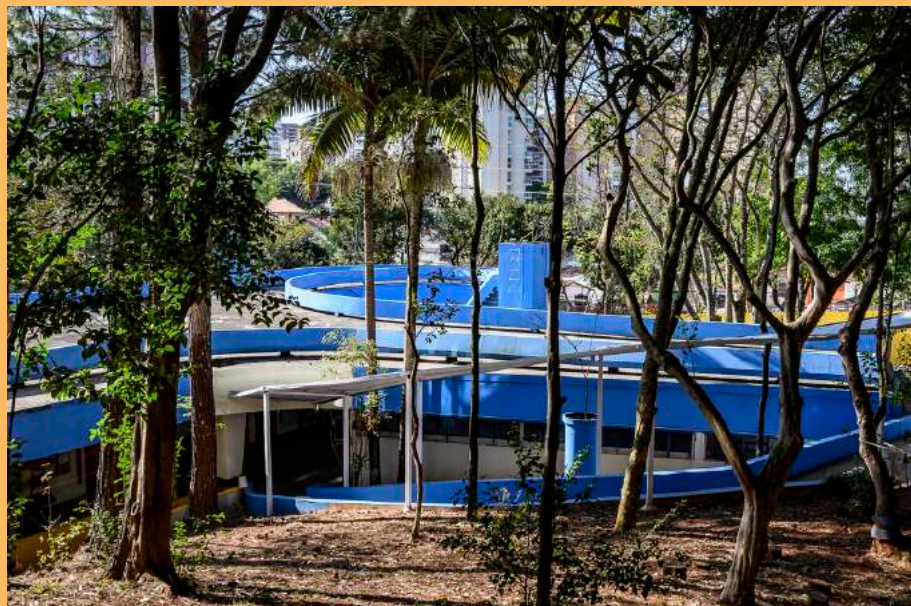
Vista geral da laje terraço, em primeiro plano o acesso às salas de aula. Foto: Beto Garavello, julho de 2022. Coleção CTAPC.
