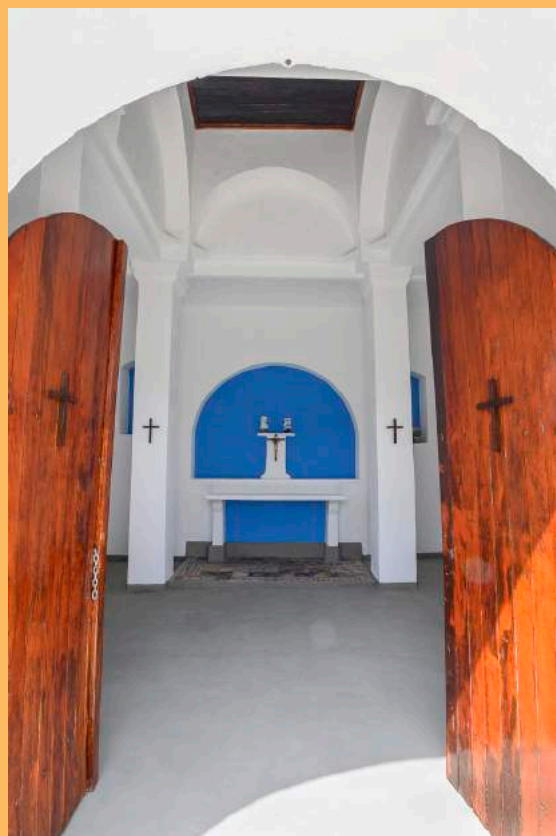
Vista interna da Capela de São José da Boa Viagem, após intervenção finalizada em agosto de 2022. Destacam-se as portas, a estrutura da edificação e, ao fundo, o altar. Foto Beto Garavello, setembro de 2022. Coleção CTAPC.
