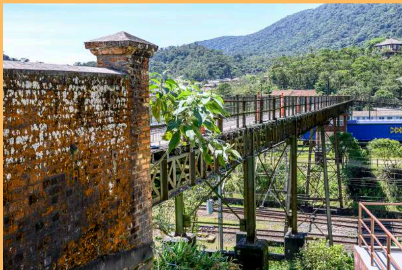
Passarela metálica denominada Ponte Francisca Cavalcanti de Araújo que liga a Parte Alta ou Morro da Capela à Parte Baixa. Em primeiro plano, vê-se o muro de arranque em tijolos e abaixo o pátio ferroviário. Ao fundo, vê-se o Parque Natural Municipal Nascentes de Paranapiacaba e o Castelinho, antiga residência do engenheiro chefe. Foto Beto Garavello, setembro de 2022. Coleção CTAPC.
