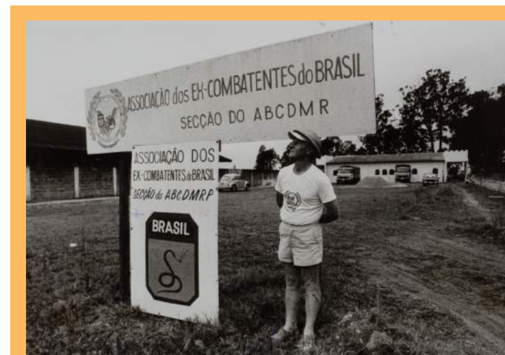
Álvaro Muraro, então presidente da Associação dos Ex-Combatentes do ABCDMRR, junto à placa de identificação da Associação. Ao fundo, a edificação ainda em construção, agosto de 1988. Coleção PSA. Acervo MSAOAG.
