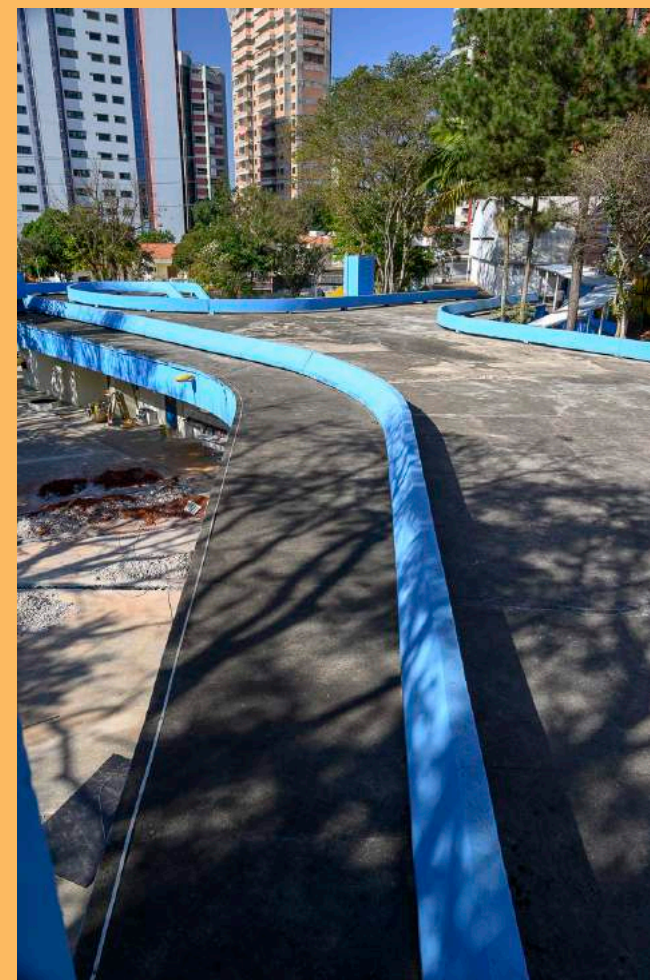
Laje terraço que funciona como um pátio descoberto e cobertura das salas de aula existentes no pavimento inferior. Ao fundo bifurca à direita, acessa o nível intermediário, chegando à quadra de esporte e, no térreo, às salas de aula; à esquerda dá acesso à área de recreação e a outras áreas da escola. Foto: Beto Garavello, julho de 2022. Coleção CTAPC.
