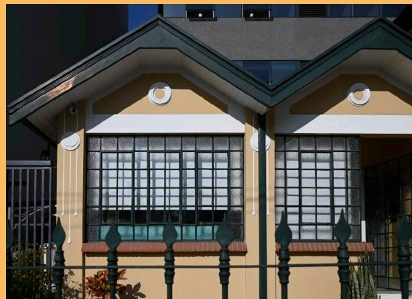
Detalhe da varanda que originalmente era aberta. Nota-se o rebatimento do telhado de duas águas que garante movimento à fachada. Observe-se que a fachada é decorada com elementos de linguagem Art Noveau em estuque. A varanda foi fechada com vidro e esquadria em ferro, e parapeito finalizado com pingadeiras em cerâmica. Julho de 2022. Foto de Beto Garavello, julho de 2022. Coleção CTAPC.
