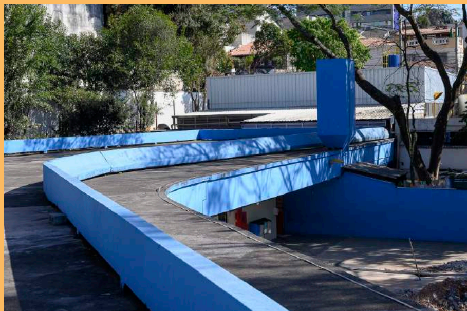
Laje terraço. Notar o guarda corpo e caixa d'água em concreto armado. À direita vê-se o pátio de acesso às salas de aula e ao fundo a área da antiga piscina da escola, hoje ocupada pelo NANASA. Foto: Beto Garavello, julho de 2022. Coleção CTAPC.
