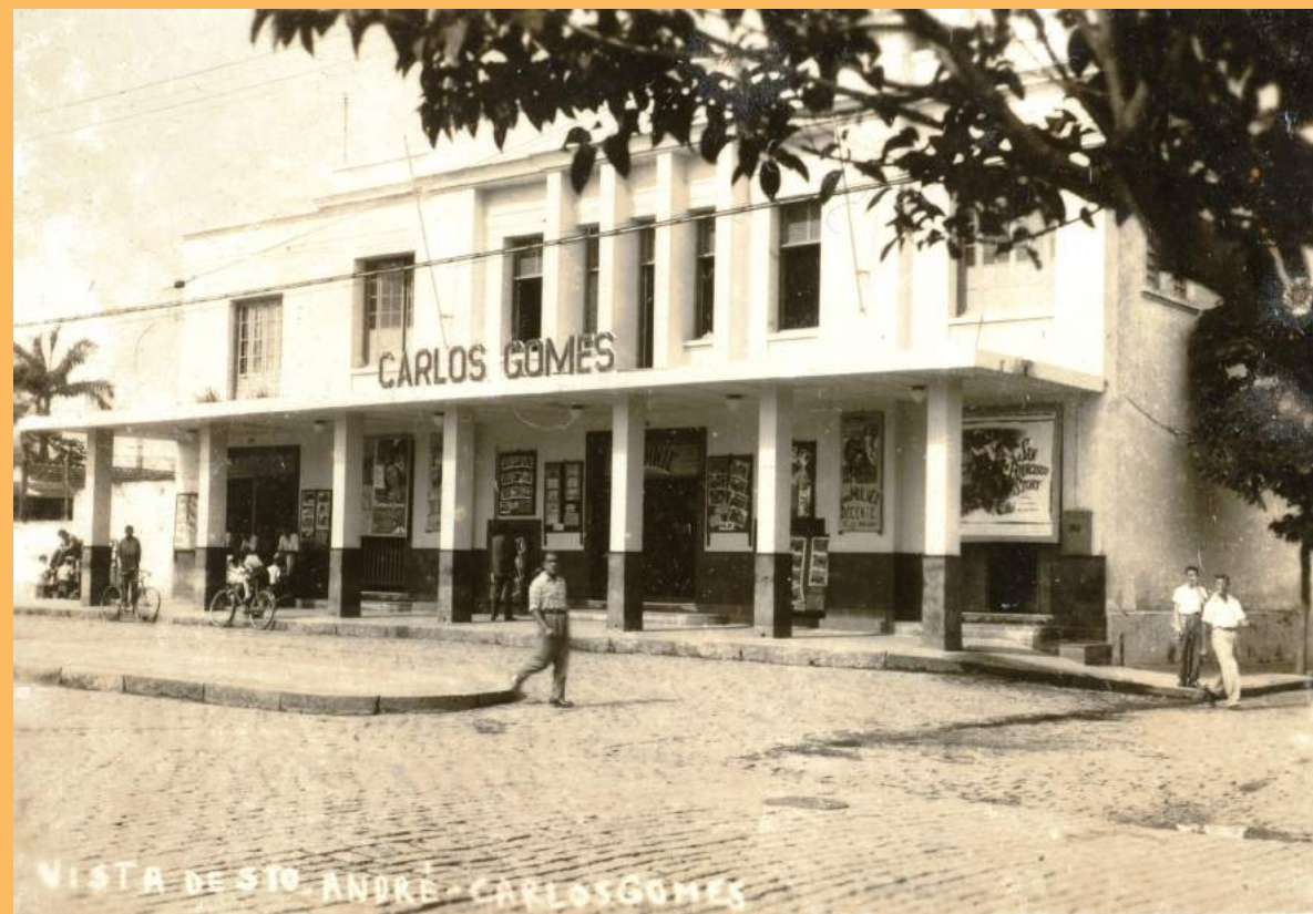
Fachada do Cine Theatro Carlos Gomes após a reforma de modernização, 1953. Foto Leite. Coleção Alice Lobo. Acervo MSAOAG.
