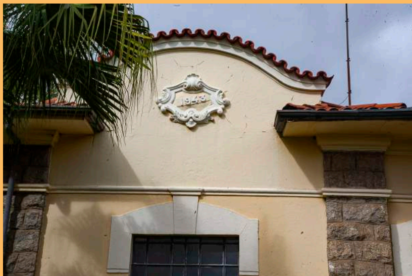
Detalhe da lateral da fachada principal com destaque para as falsas pilastras em pedras onde se apoiam os beirais e para o brasão decorativo com a inscrição da data de construção da Estação de Tratamento de Água Guarará. Foto David Rego Jr., agosto de 2022. Coleção CTAPC.
