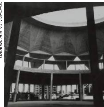
Detalhe da construção do prédio da Câmara Municipal, com destaque para os pilotis e a coroa que encima a edificação, c.1967.
