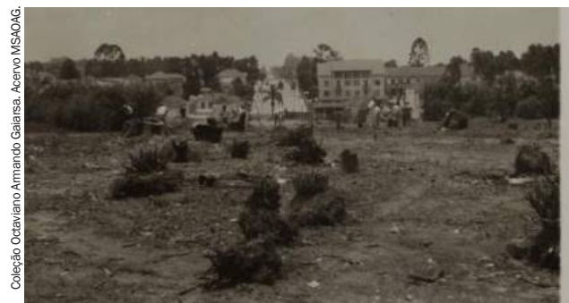
Obras na Chácara Bastos para construção da Praça IV Centenário. Ao fundo, Av. Dom Pedro II, década de 1950.
