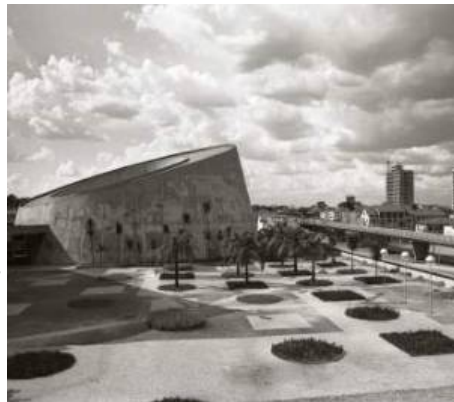
Detalhe do calçamento e paisagismo do Centro Cívico, junto ao centro cultural, início da década de 1970.
