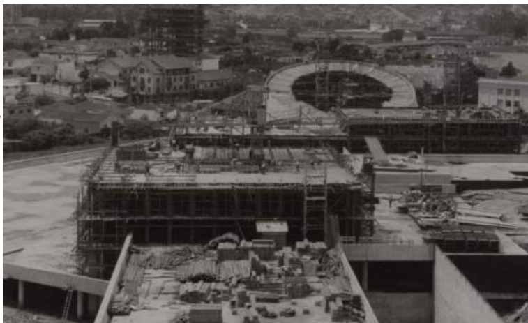
Vista da construção do Centro Cívico. Em primeiro plano o Executivo praticamente sem andares, em seguida, o prédio do Centro Cultural e após, o Teatro. Ao fundo na foto, vê-se o atual prédio da ACISA, final da década de 1960.
